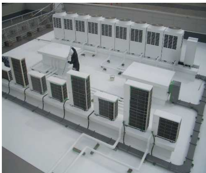
1階屋上 施工状況 (26年11月末)
