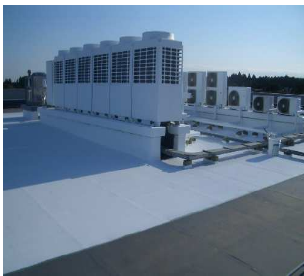
2階屋上 施工状況 (26年11月末)
